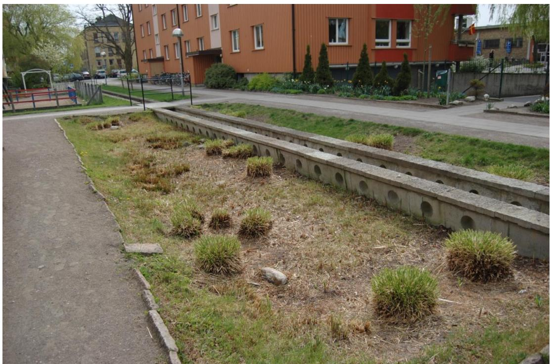
Foto 5: Systém vsaku dažďovej vody v terénnej depresii a zároveň jej odvodu v prípade príliš intenzívnych zrážok Augstenborg, Švédsko (archív autorky)
