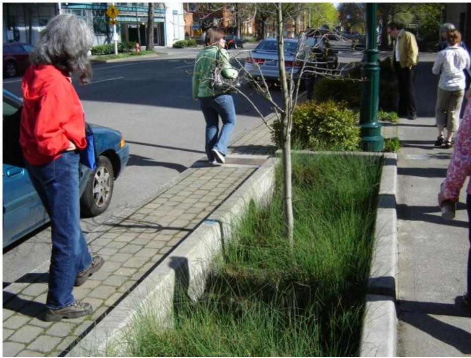
Foto 7: Bioretenčné systémy ako súčasť menežmentu dažďovej vody v uliciach, Portland, USA
